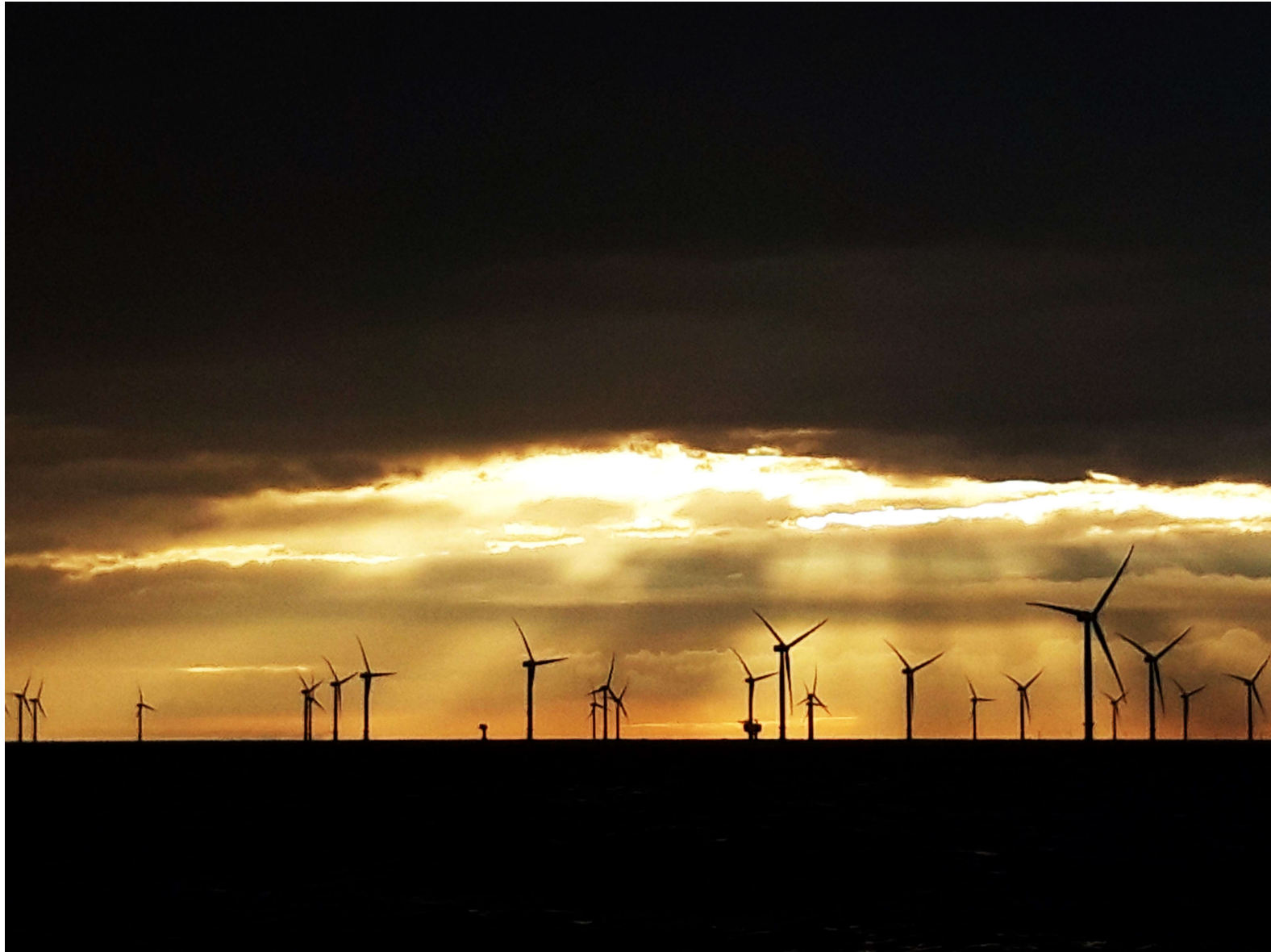
Zwischen Bornholm und Rügen sind 5 Windparks in Betrieb bzw. im Bau.
